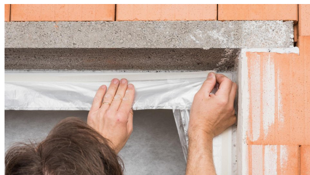
4. Fensterrahmen abkleben Dabei einen mind. 6 mm breiten Streifen auf dem Blendrahmen für den Anschluss mit AEROSANA VISCONN / FIBRE freilassen. Alternativ Fugendämmung soweit entfernen, dass eine saubere Oberfläche für den seitlichen Anschluss am Blendrahmen entsteht.
