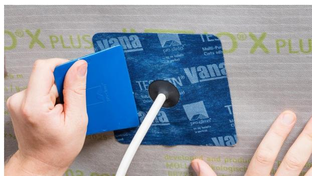
**10a. Anschluss an Kabel**
