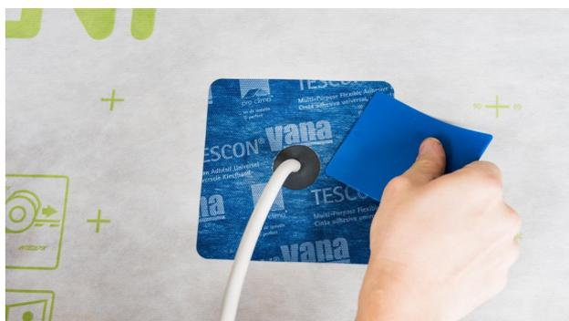
**11a. Anschluss an Kabel**
