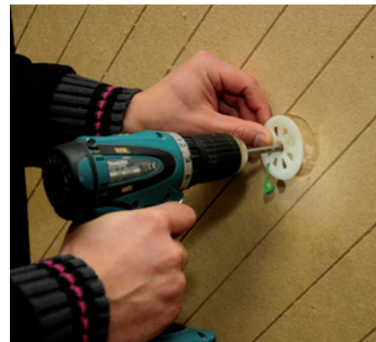
UdiMONTAGE SDM RECO® einschrauben
