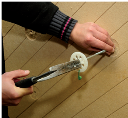
UdiMONTAGE SDM RECO® Dübel einschlagen
