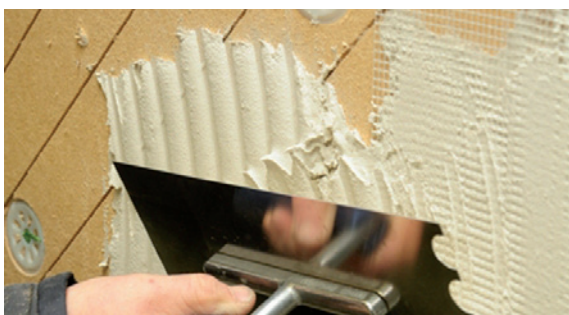
Spachtelung mit Armierung
