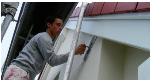
Edelputz auftragen und strukturieren
