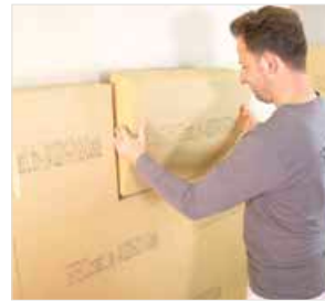
Verlegung kleinformatiger stumpfer Platten
