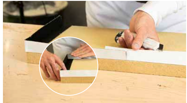
3 Die STEICOmulti tape black Klebestreifen mind. 5,0 cm überlappen, so dass sich eine dichte, dreiseitige Wanne ausbildet
