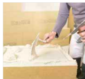
Dämmplatte ankleben auf unebenem Untergrund im Punkt-Wulst-Verfahren
