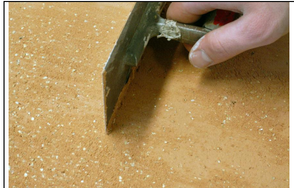
1 % Vermiculite in Kalkglätte, beige getönt, Abziehen mit der Kelle
