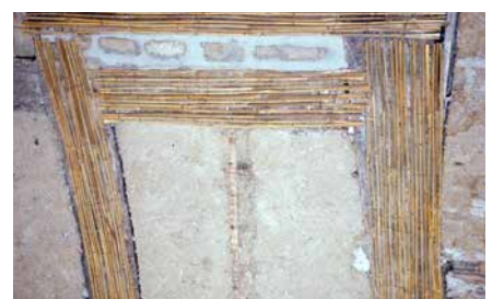
Rohrgewebe als Putzträger auf Holzbalken in der Fachwerksanierung
