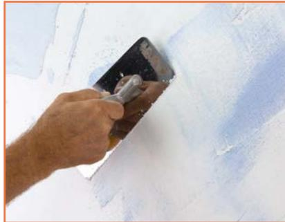
// Tragen Sie die Mischung in kurzen Zügen und wechselnden Richtungen auf
