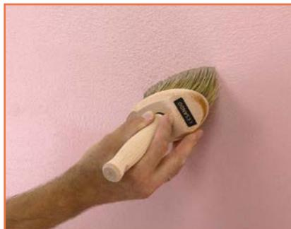
// Nach einer Standzeit von ca. 5 - 10 Min. mit der Lasurbürste etwas Wasser aufnehmen und die Fläche mit schwungvollen Bewegungen abbürsten
