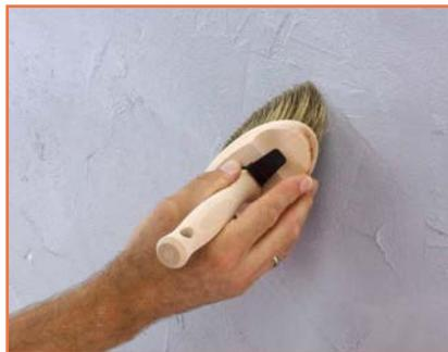
// Die Kellenschlagstruktur ca. 10 - 20 Min. ansteifen lassen und mit etwas Wasser und einer Lasurbürste die Struktur mit leichten Streichbewegungen bearbeiten
