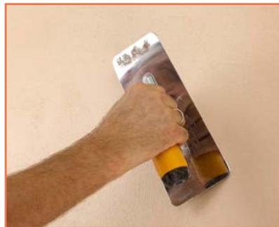
// Sofort nach dem Auftragen den Glätter mit der Längsseite auf die frische Putzschicht aufsetzen und in kurzen Zügen wegziehen
