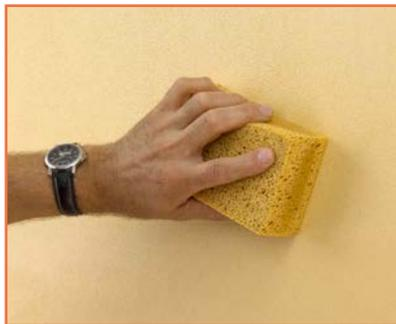
// Nach einer Standzeit von ca. 10 - 15 Min. Handschwamm nassen, gut auspressen und die Fläche in kreisrunden Bewegungen mit mäßigem Druck abreiben
