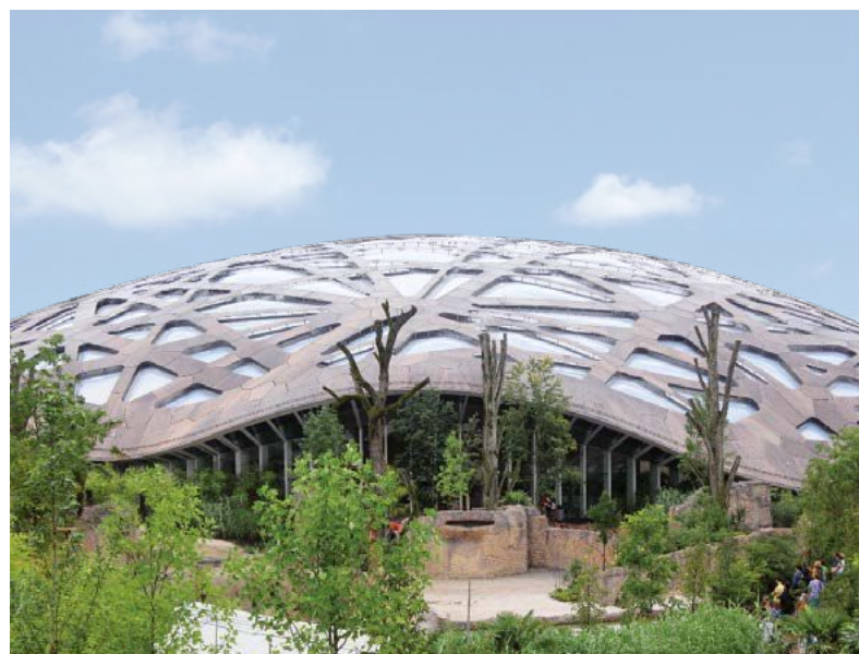
esb im Objektbau: Elefantenhaus in Zürich
