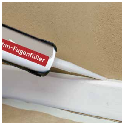
Fugenfüllung mit natur-weiß an einer Sockelleiste
